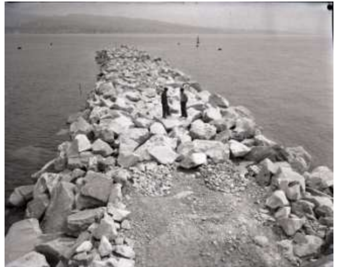
Enrochements de digue
