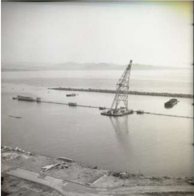
Pose des blocs avec ponton Mâtire
